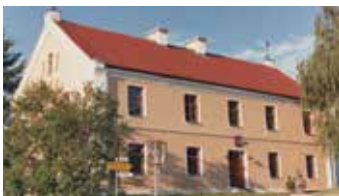
Kissing Alte Schule Bachernstraße 1, 86438 Kissing
